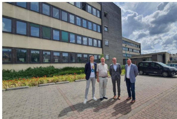
.Dit gebouw van het vrederecht en de politierechtbank wordt verbouwd tot rechts een school en links een zorggebouw met onder meer kinderopvang. — © idh
